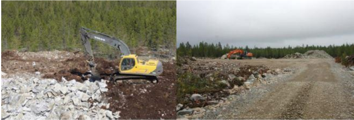
Kuva 28. Tuulivoimapuiston rakentaminen alkaa huoltoteiden ja pystytysalueiden rakentamisella (FCG).
