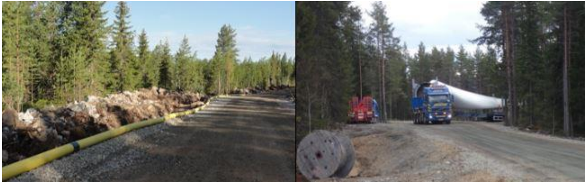
Kuva 27. Vasemmalla esimerkki tuulivoimapuiston rakennus- ja huoltotiestä. Oikealla tuulivoimalan osia kuljetetaan erikoiskuljetuksina (FCG).
