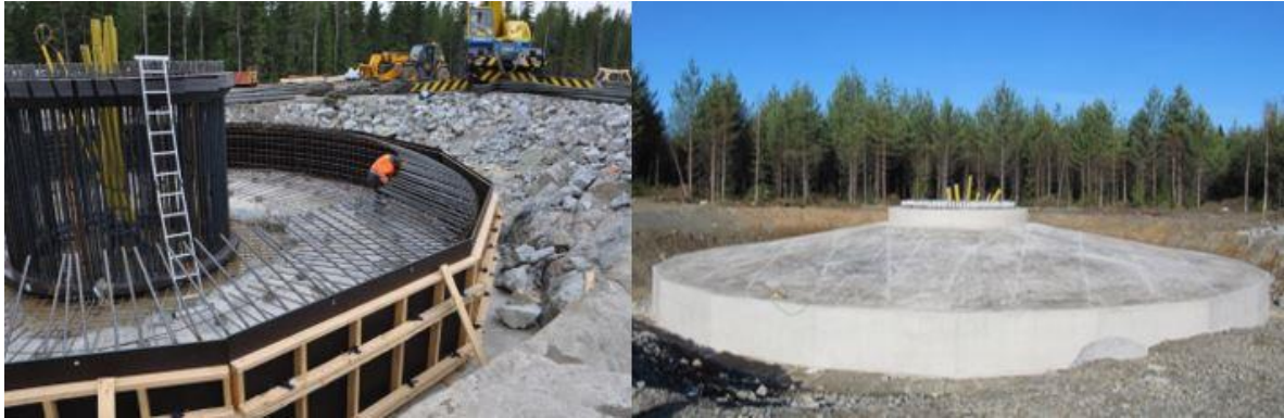
Kuva 29. Tuulivoimalan perustusten rakentamista (FCG).
